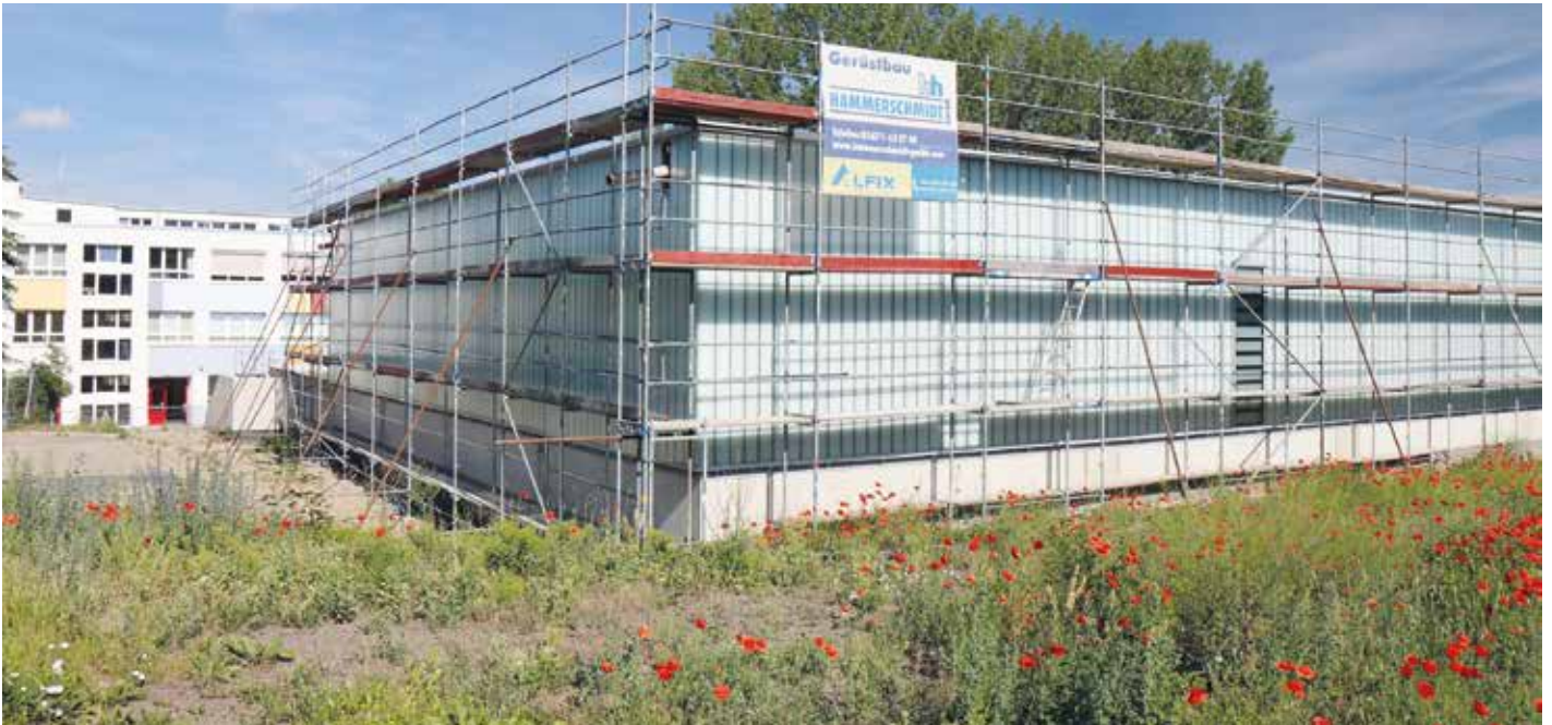
Die neue Zweifeldhalle am Erasmus-Reinhold-Gymnasium in Saalfeld ist die größte Schulinvestition des Landkreises in diesem Jahr. Die Halle soll zum neuen Schuljahr nutzbar sein. Der Anbau wurde gegenüber dem ursprünglichen Entwurf um einen größeren Mehrzweckraum und ein Außensportgeräteraum erweitert und wird voraussichtlich im September fertig. (Foto: Peter Lahann)
