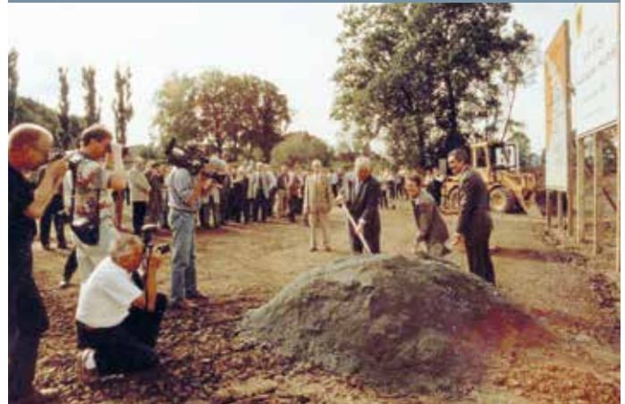
Am 7. September 1998 erfolgt der symbolische erste Spatenstich für die Nordtangente (B281) in Saalfeld. Am 18. Juni 2001 wird der knapp 72 Millionen D-Mark teure Streckenabschnitt für den Verkehr freigegeben. (Foto: Klaus Moritz)
