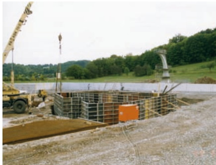
Sanierung des Schwimmerbeckens 1999. (Bildarchiv Stadtmuseum Saalfeld)
