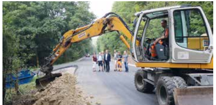
Karl-Friedrich Heinecke vom Sachgebiet Tiefbau (links) erläutert Landrat Marko Wolfram die ausstehenden Arbeiten. Polier Matthias Reichow und René Wohlfahrt im Bagger gehören zur ausführenden Firma. (Foto: P. Lahann)
