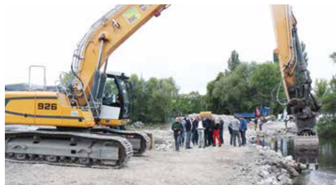
Mit einem symbolischen Baggergriff begannen jetzt die Arbeiten am Umbau des Zeisswehres in Saalfeld. (Foto: P. Lahann)
