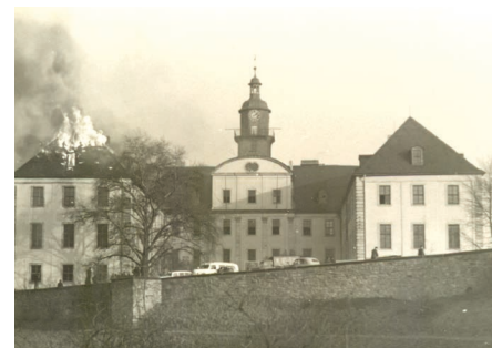
Brand im Saalfelder Schloss, 1953. (Quelle: Freiwillige Feuerwehr Saalfeld)
