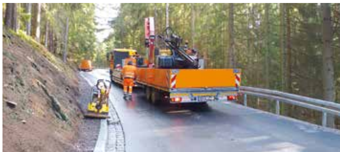
Die K137 zwischen Mellenbach und Lichtenhain konnte eine Woche vor dem geplanten Termin freigegeben werden. (Foto: K. Sommer)
