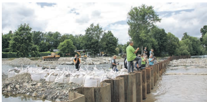
Nach der Einweihung der Sohlgleite in Riegelbauweise am ehemaligen Zeisswehr wurde am ehemaligen Teilewehr mit einem Durchstich der Saale der Startschuss für den zweiten Bauabschnitt dieses Wehrs gegeben. Für die Gäste wurde von der Baufirma eine Art Tribüne inmitten der Baustelle auf der Saale eingerichtet, die durch Spundwände vom Fluss abgetrennt ist. Fotos: Martin Modes
