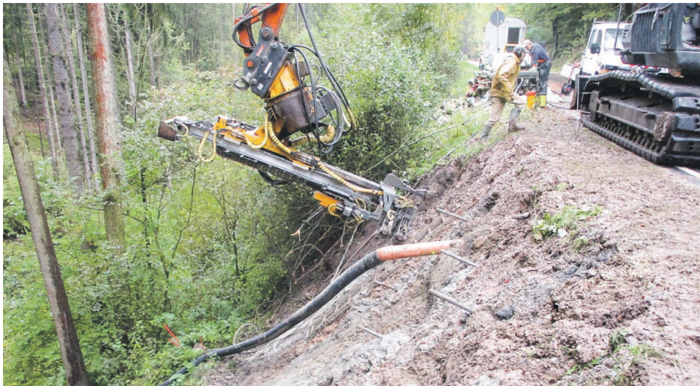
Bei Partschefeld konnte an der Kreisstraße 113 eine Hangrutschung im Bereich eines Straßenablaufs saniert werden. Die Arbeiten mit einem Kostenvolumen von 46.000 Euro konnten kurzfristig in das Investitionsprogramm des Landkreises Saalfeld-Rudolstadt für das laufende Jahr eingeordnet werden. (Foto: LRA/Dirk Büchner)
