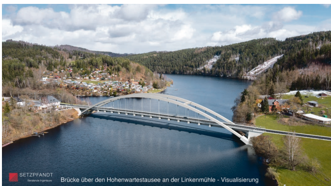
So könnte die Stabbogenbrücke an der Linkenmühle aussehen. (Graphik: Büro Setzpfand Ingenieure)
