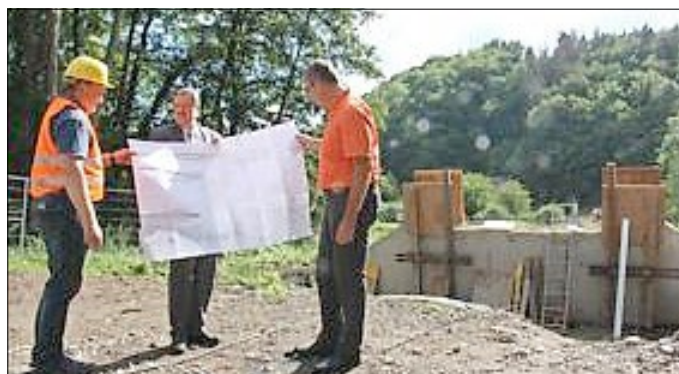
Marko Wolfram, Landrat des Landkreises Saalfeld-Rudolstadt, und Saalfelds Bürgermeister Dr. Steffen Kania besahen am Mittwoch gemeinsam den aktuellen Baufortschritt für die neue Radwegebrücke zwischen Oberrnitz und Reschwitz
