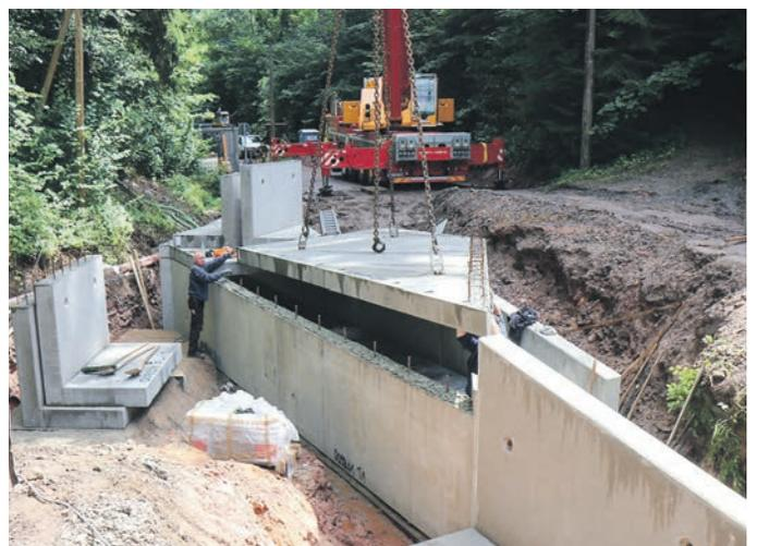
**Präzisionsarbeit** war an der Brückenbaustelle an der K 113 zwischen Partschefeld und Uhlstädt erforderlich. Im engen Tal wurden die Betonfertigteile über die Bäume bis an den Uhlsbach gezirkelt und dort von den Mitarbeitern der Baufirma Torus GmbH aus Königsee zusammengesetzt. Wie bei einem großen Tetris-Spiel müssen die tonnenschweren Brückenelemente zentimetergenau eingepasst werden. Knapp 180.000 Euro an kreiseigenen Mitteln kostet der Ersatzneubau. (Foto: Peter Laham)
