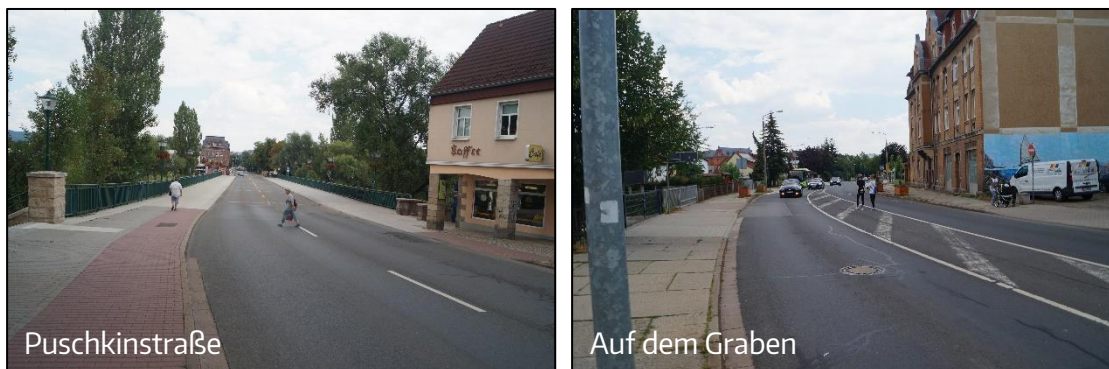
Abb. 8 Querungsdefizite im Hauptstraßennetz
