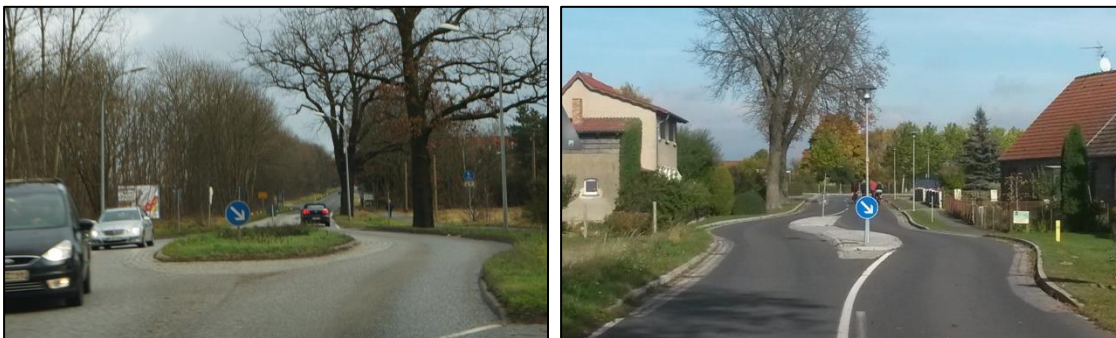
Abb. 28 Beispiele Ortseingangsgestaltung mit Fahrstreifenversatz
