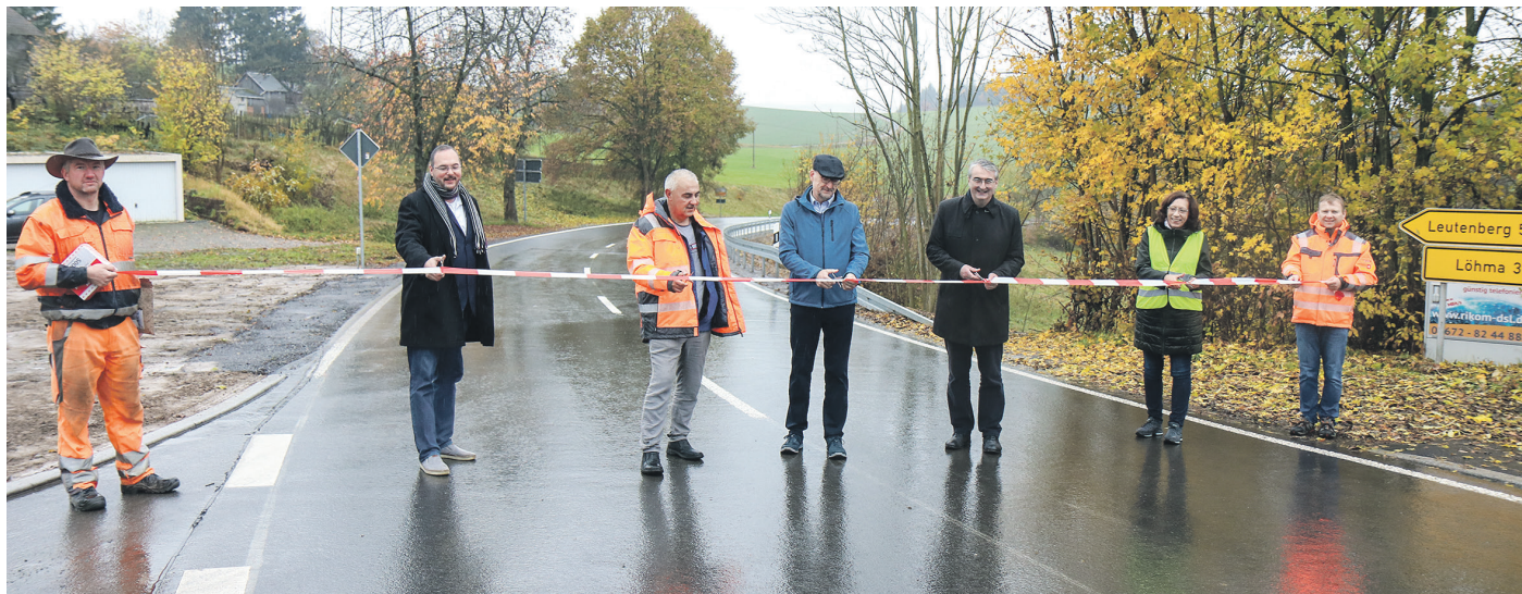
Symbolische Freigabe der K 166 von Steinsdorf nach Leutenberg zum Ende des dritten Bauabschnitts: v.li. Polier Stefan Rosenfeld, Bürgermeister Robert Geheb, Bauleiter Lutz Krüger, Ortsteilbürgermeister Michael Höltzer, Landrat Marko Wolfram, Planerin Birgit Weise, Bauingenieur Kai Sommer. (Foto: Martin Modes)
