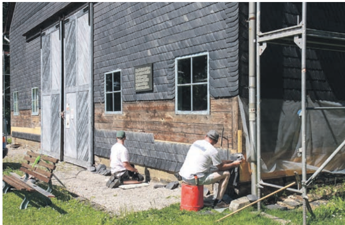
Sanierung der Großen Scheune 2013.
