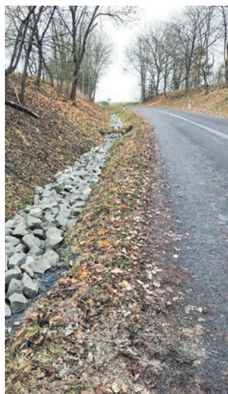
Die provisorische Sanierung hat begonnen.
