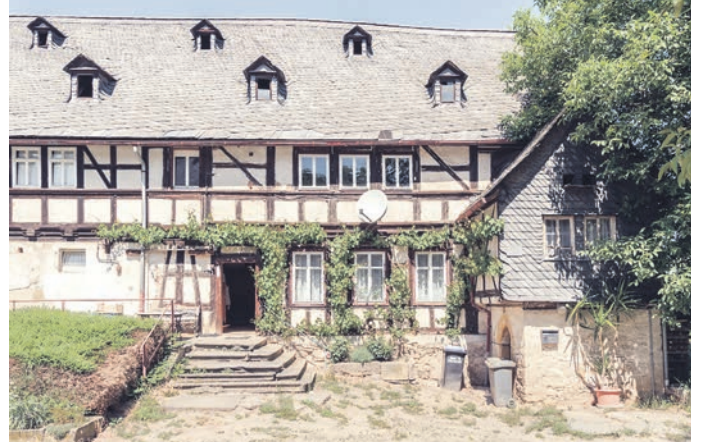
Schöner Fachwerkhof in Garnsdorf. Bei der Beratung durch den Architekten standen insbesondere die Themen Sanierung und Fördermöglichkeiten bei Umbau- und Sanierungsmaßnahmen für den Eigentümer im Vordergrund. Architekt und Bildautor: Tino Rabold
