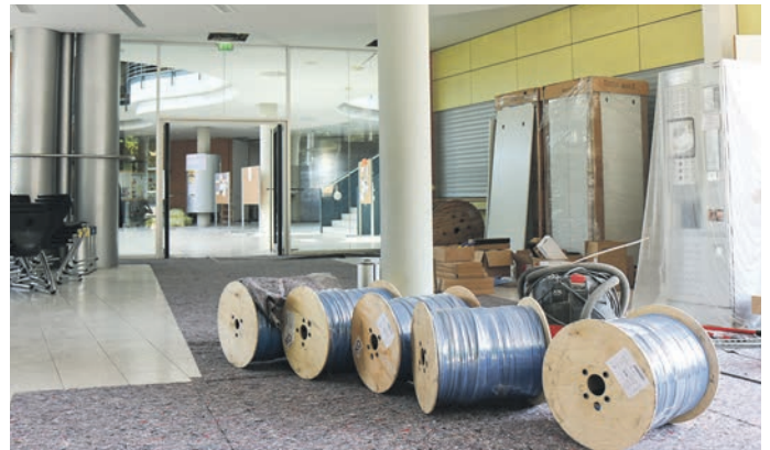
In der Mensa des Böllgymnasiums liegen Rollen mit Netzkabeln, die jetzt im Neubau verlegt werden. (Foto: R. Thümer)
