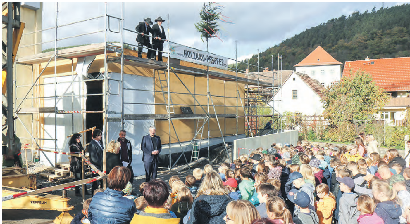
Das Richtfest am Erweiterungsbau der Grundschule „Heinrich Heine“ in Uhlstädt wurde am Mittwoch, 2. November, gefeiert. Landrat Marko Wolfram dankte den beteiligten Firmen und Planern für die geleistete Arbeit. Bis Anfang des nächsten Schuljahres soll das Gebäude bezugsfertig sein. Die Schule leidet seit Jahren aufgrund der unerwartet hohen Schülerzahlen an Platzmangel. (Foto: Peter Lahamm)
