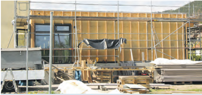
In Uhlstädt ist der Innenausbau in vollem Gange, die Fassade wird unterdessen mit Lärchenholz verschalt. (Fotos: Peter Lahann)
