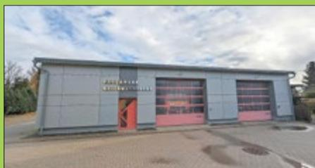
Das Feuerwehrgerätehaus in Reichmannsdorf wurde umfassend saniert. Das Objekt, das aus zwei Fahrzeughallen und einem Umkleide- und Werkstattbereich besteht, befand sich in einem schlechten Zustand und wurde u.a. im Bereich Mauerwerk, Dach erneuert.
