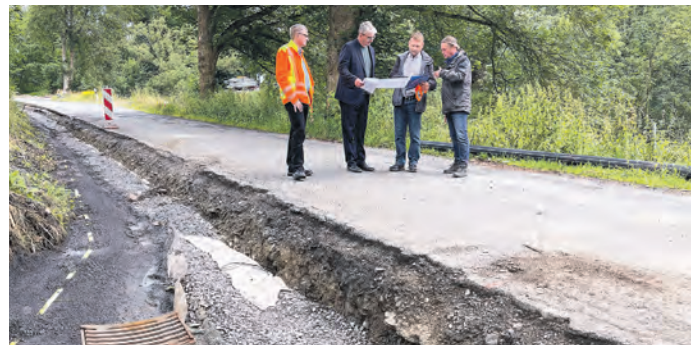
Die K171 nach Neuenbeuthen wird saniert und verbreitert.
