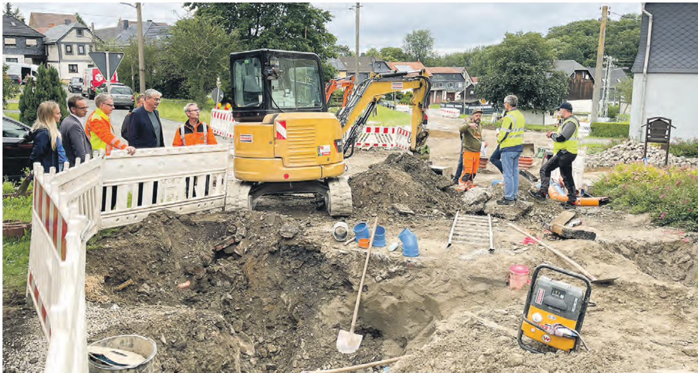
Aktuell laufen im Landkreis millionenschwere Bauarbeiten an Kreisstraßen wie hier in Dorfilm. Hier bauen ZWA, TEN, Gemeinde und Landkreis gemeinsam Abwasser, Trinkwasser, Stromversorgung, Breitband, eine barrierefreie Bushaltestelle und die Kreisstraße in der Ortsdurchfahrt. (Foto: Peter Laham)
