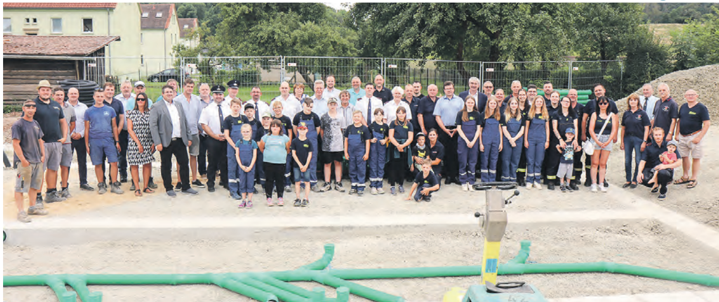
Zur Grundsteinlegung für das neue Feuerwehrgerätehaus in Großkochberg waren große und kleine Kameradinnen und Kameraden, Vertreter des Gemeinderates, der Baufirmen, vom Amt für Bevölkerungsschutz und weitere Gäste zur Baustelle gekommen. Bürgermeister Frank Dietzel und Landrat Marko Wolfram dankten den Feuerwehrleuten für ihren großartigen Einsatz. (Foto: Peter Laham)
